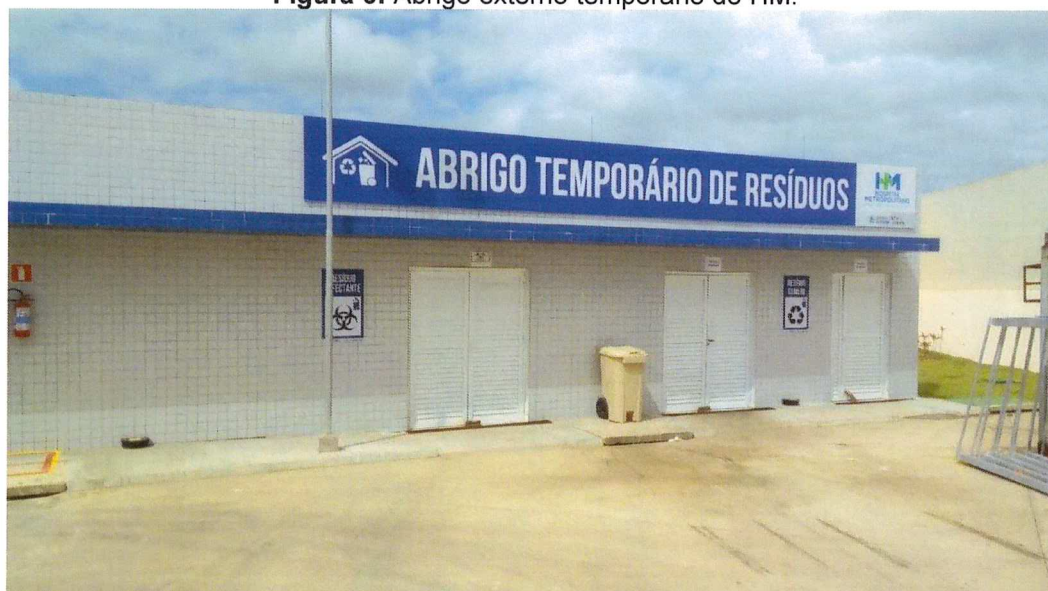
Figura 6: Abrigo externo temporário do HM.
